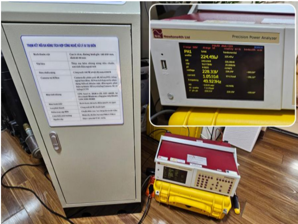
Hình 6. Thiết lập thử nghiệm đo đánh giá công suất của hệ thống
